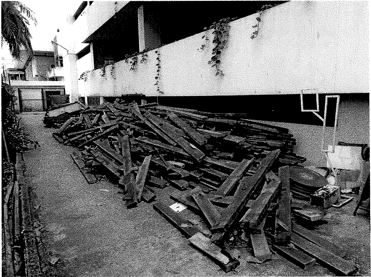
งานปรับปรุงและตกแต่งภายในห้องประชุมพิมานมาศ ชั้น 11 อาคารจอดรถ
