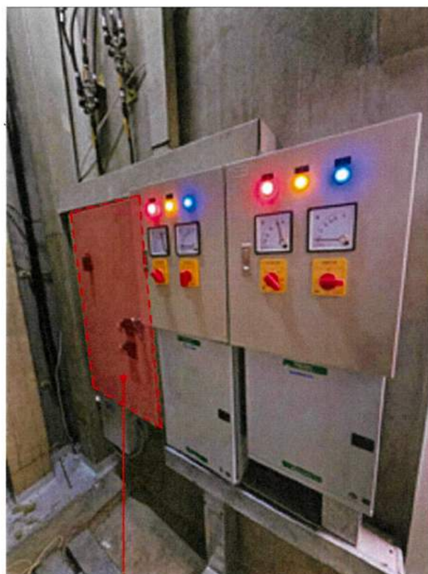
รื้อถอนตู้ Line Normal ของเดิมพร้อมติดตั้งตู้ใหม่ทดแทน
