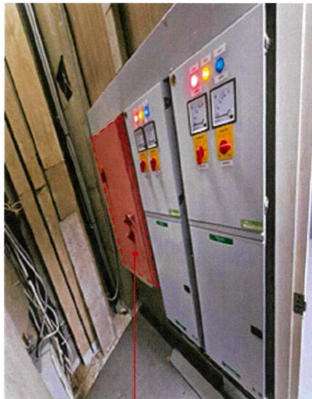
รื้อถอนตู้ Line Normal ของเดิมพร้อมติดตั้งตู้ใหม่ทดแทน
