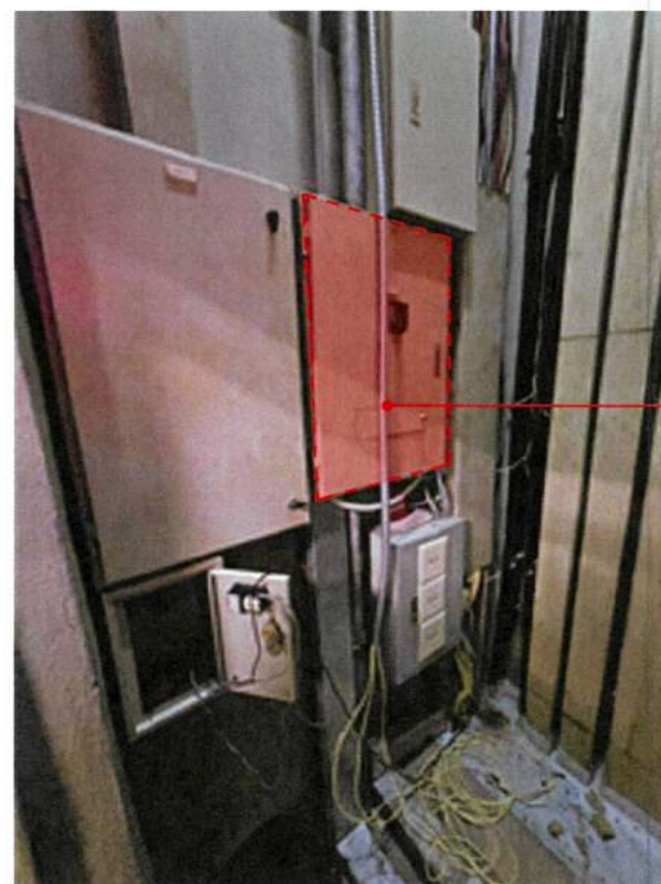
รื้อถอนตู้ Line Normal ของเดิมพร้อมติดตั้งตู้ใหม่ทดแทน
