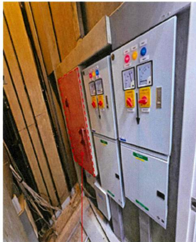
รื้อถอนตู้ Line Normal ของเดิมพร้อมติดตั้งตู้ใหม่ทดแทน
